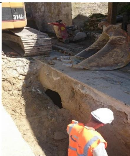
Devant la halle, la tranchée révèle l'orifice de l'ancien puits (6 mètres de profondeur) partiellement situé sous la chaussée. La paroi sera maçonnée pour préserver ce puits potentiellement réutilisable
